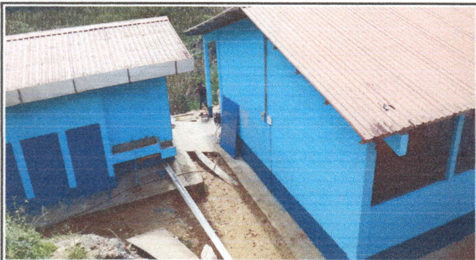
Foto1: se indentifica el avance del mantenimiento de las puertas y la aplicación de pinturas
