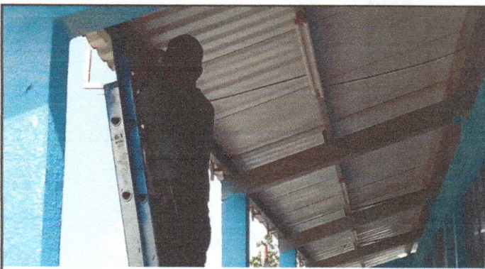
Foto 4: se indentifica el avance de la instalacion de canales y pescantes
