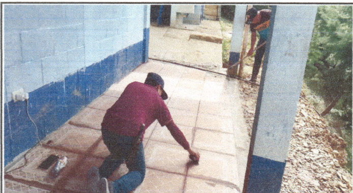
Foto 3: Se observa el avance de la instalacion de ceramico en el corredor del Establecimiento
