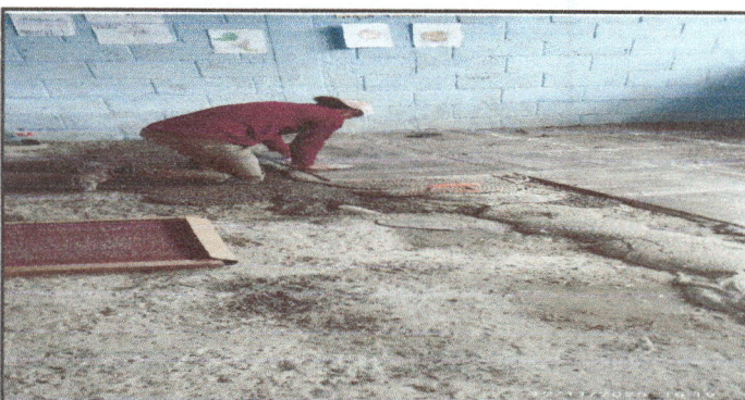
Foto 6: Se observa la instalacion de piso ceramico aula I
